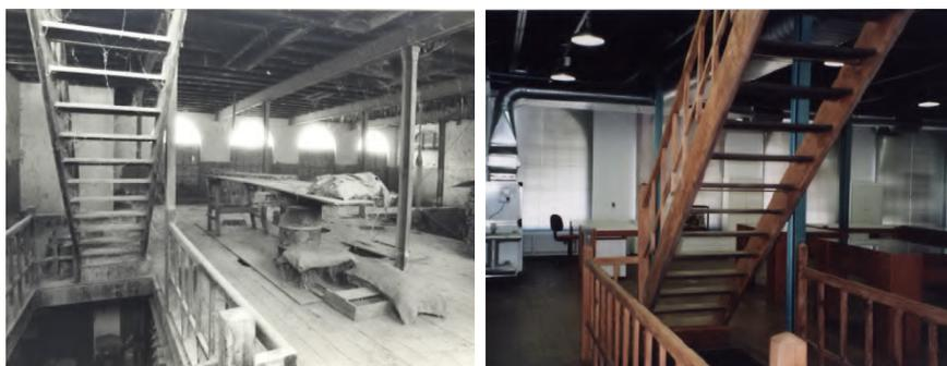
**Figuras 32 e 33. Escada em madeira no interior do antigo engenho, antes (em 1982) e depois da intervenção**
