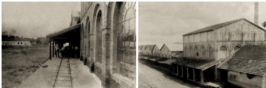
**Figuras 16 e 17. Imagens do antigo conjunto KKKK, destacando-se o alpendre que conectava os diversos pavilhões e os trilhos com carro para transporte de produtos.**
