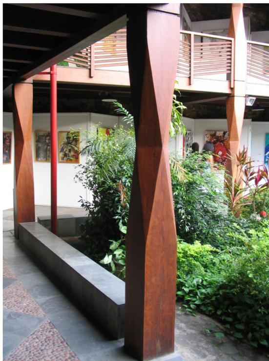
**Figura 13. Detalhe da coluna em forma de pilão que sustenta a galeria do pátio central.**
