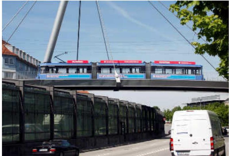
**Abbildung 20: Die Münchner Straßenbahnlinie 23 überquert den Mittleren Ring auf einer Tragseilbrücke**
