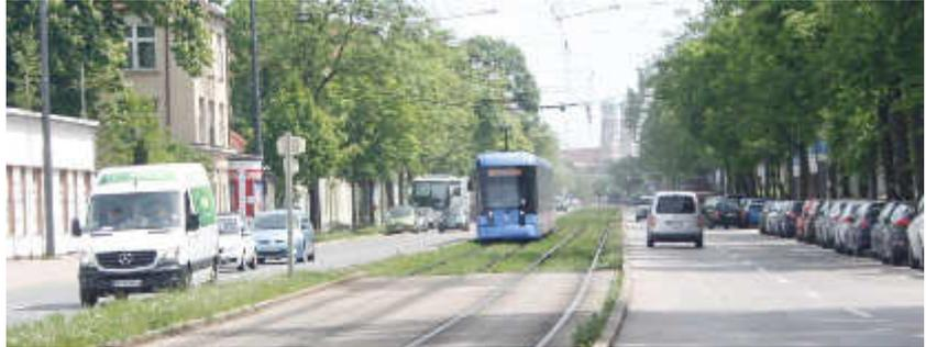
**Abbildung 14: Besonderer Gleiskörper mit Rasengleis in München**
