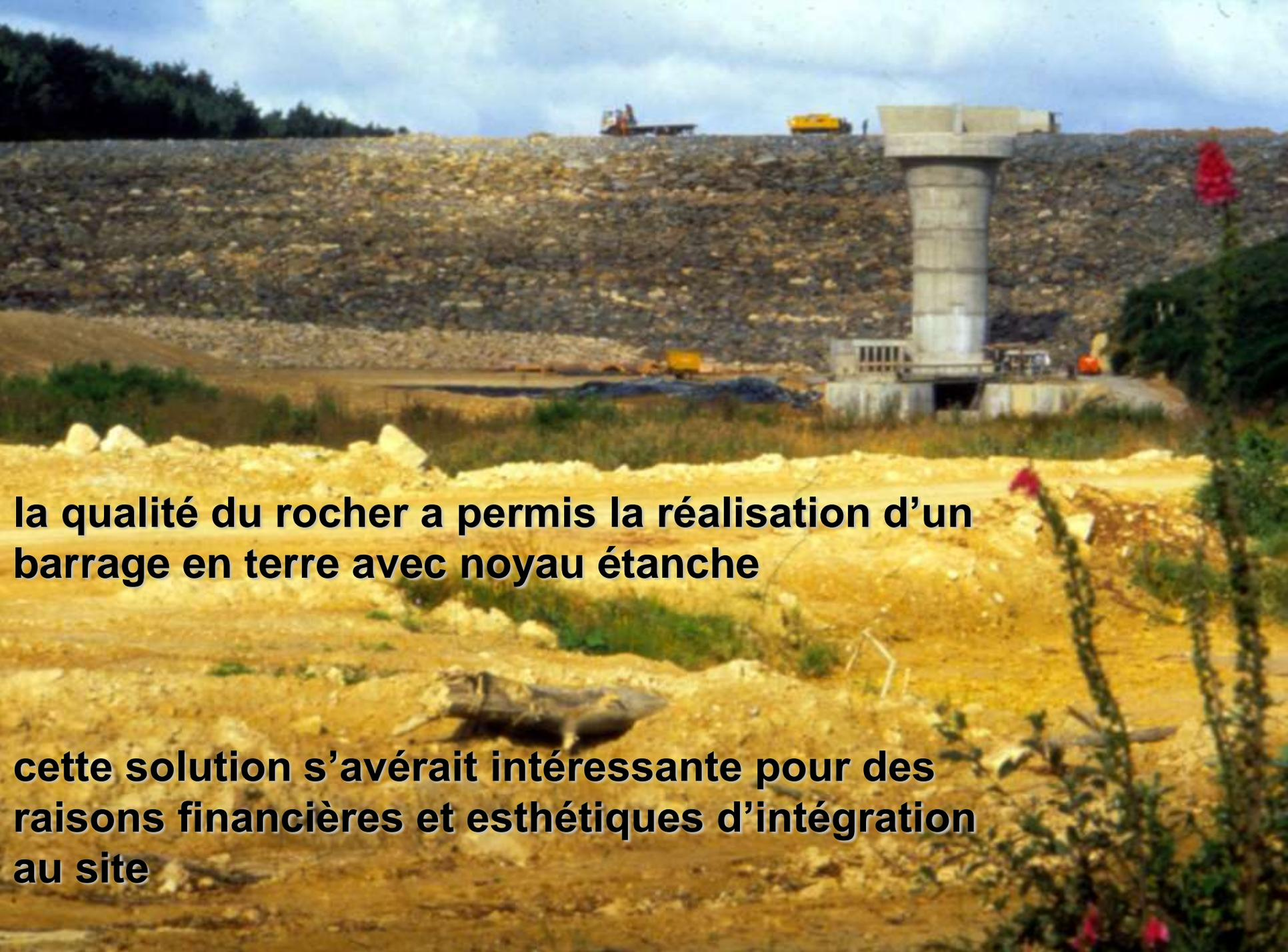
**la qualité du rocher a permis la réalisation d'un barrage en terre avec noyau étanche**
