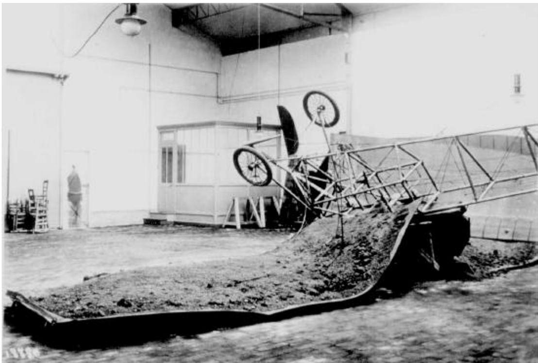
*Suite aux crashes dus à des bris de structure, on procède chez les constructeurs à des essais de résistance des matériaux, en posant des sacs de sable sur les ailes jusqu'à rupture. Test chez Farman à Billancourt en 1911. (Archives municipales de Boulogne-Billancourt).*
