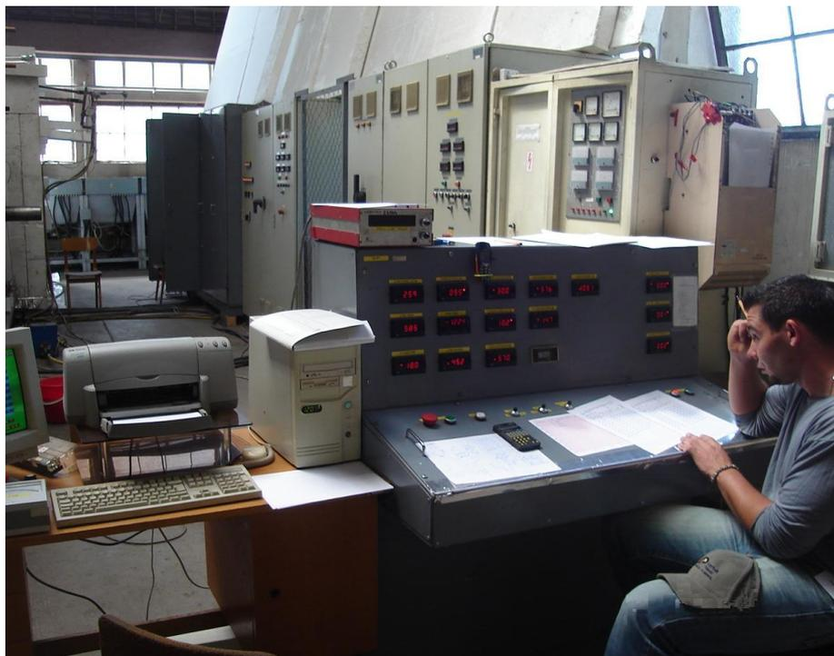
Kontrollzentrale mit Messgeräte-Panel und automatisierter Computer-Registrierung aller Messdaten.
